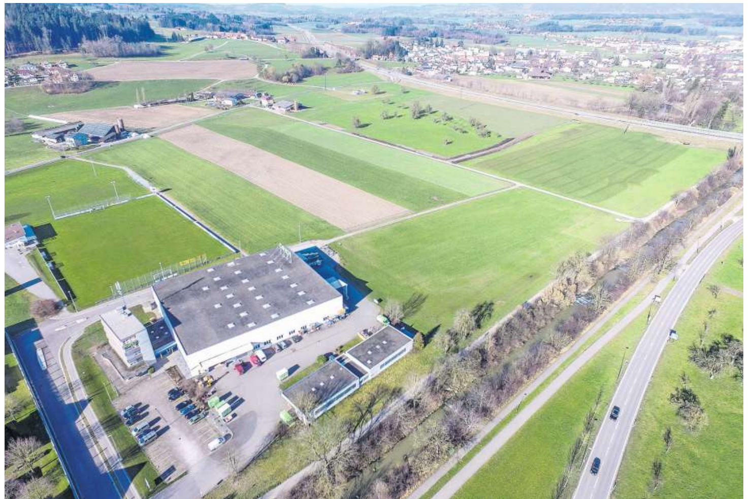
Der Fachmarkt Ebnet entsteht zwischen der Portas AG und der Autobahn A1.
