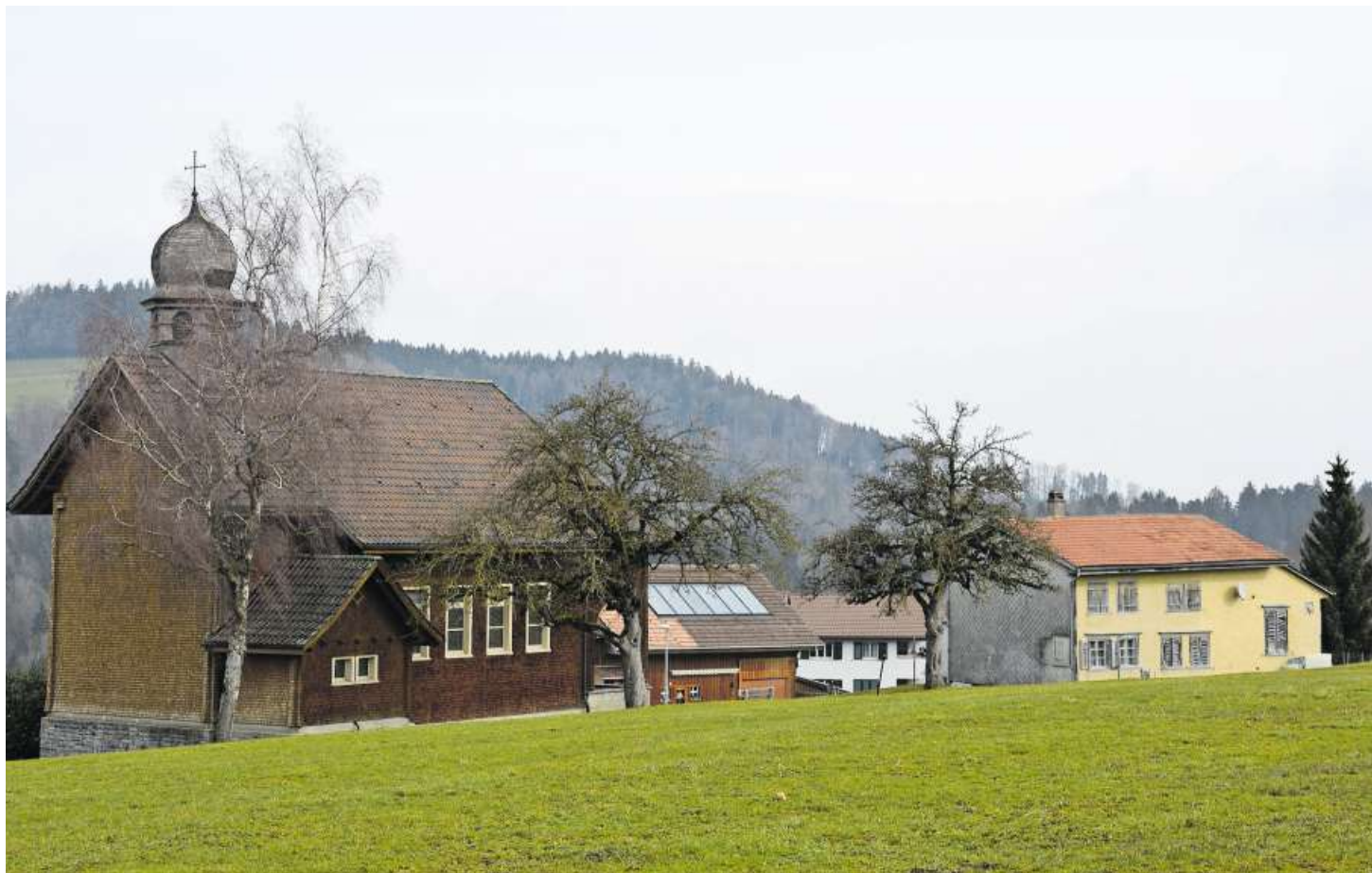
Das Haus «Stolz» (ganz rechts) befindet sich in unmittelbarer Nähe zur Müselbacher Kapelle. Es soll laut Kirchberger Kirchenverwaltung abgerissen werden und einem Kulturraum Platz machen, den wiederum der Dorfverein realisiert. Bilder: Beat Lanzendorfer
